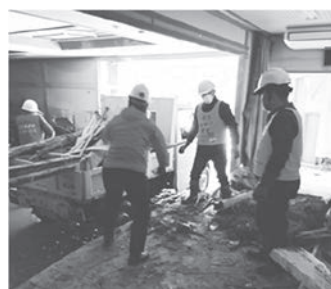
地震と豪雨被害を受けた珠洲市の旅館・海楽荘で瓦礫、土砂の撤去作業をする人々(2025年2月23日、同市真浦町)
